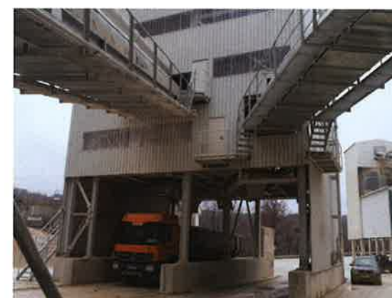
Bild 2: Verladung und Abtransport im Schotterwerk
